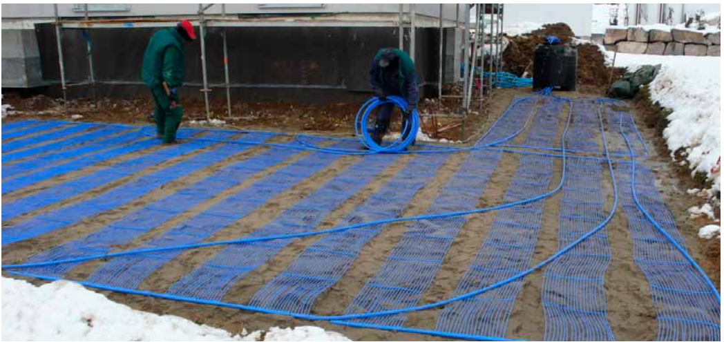
Einbau von Flächenkollektoren
