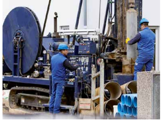
Durchführung einer Erdwärmesondenbohrung
